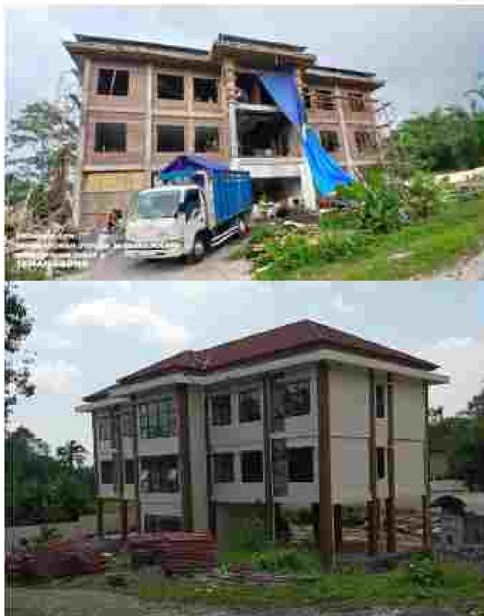
Gambar 3.8 Pembangunan Gedung Shapara Polres Temap II
